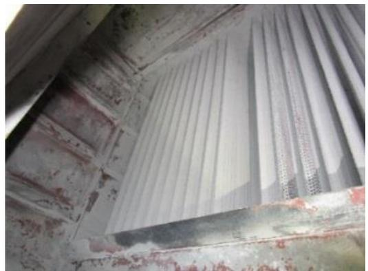
Blick in den Gewebefilter mit den Filterschläuchen (auf dem Foto links unten erkennt man gut den auf der Außenseite der Filterschläuche abgeschiedenen Filterstaub)
